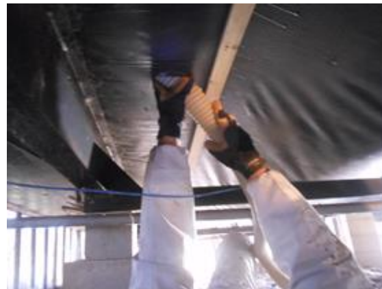
Insuflado desde abajo de la vivienda: Un tubo flexible de gran tamaño rellena los huecos rápidamente desde abajo.
