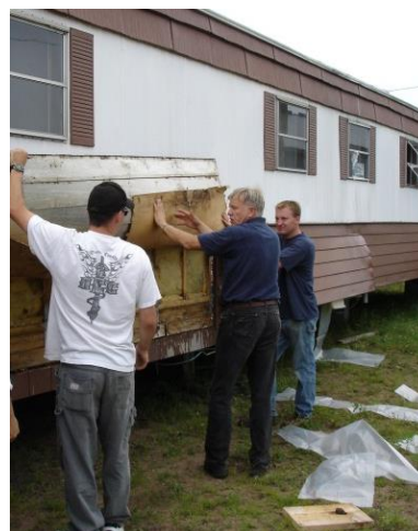
Afijado del revestimiento para aislar las paredes: Destornille los laterales de la base del revestimiento metálico. Antes de colocar el aislante, ajuste las piezas de revestimiento en sus bases con tornillos cortos.
